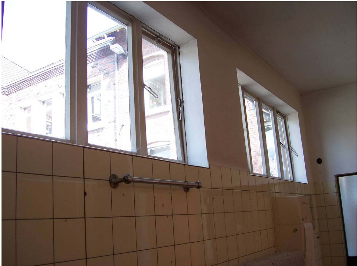
Dhünnberg 15, Thomas-Morus-Schule: WC-Anlage, Innenansichten
