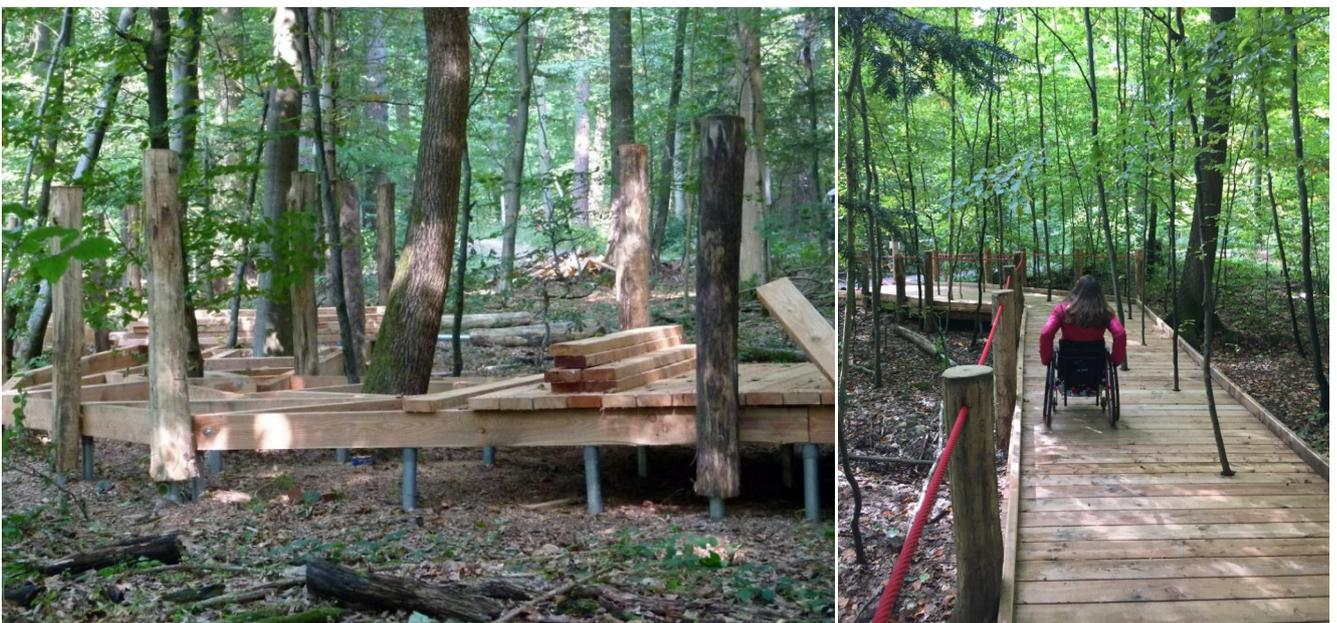
Holzsteg auf Schraubfundamenten . Holzunterkonstruktion und Beplankung aus Holz - mit „konstruktivem Holzschutz“
