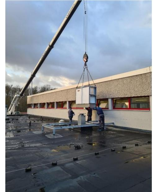
Die Technik im UG wird saniert, die Lüftung wurde auf das Dach verlegt, die Heizung läuft. Die Böden der Umkleiden sind erneuert, in den Hallen wird der Sportboden erneuert, danach die Prallwandbekleidung.
