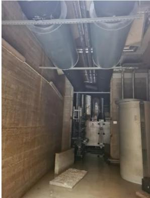
*Der Technikraum im UG wurde völlig überflutet, die Einrichtung zerstört. Die Böden und Wände der Halle wurden zerstört.*
