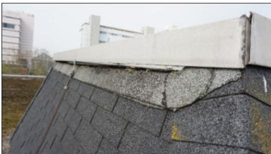
Abbildung 8: Dachaufbau, Spalten hinter Attika
