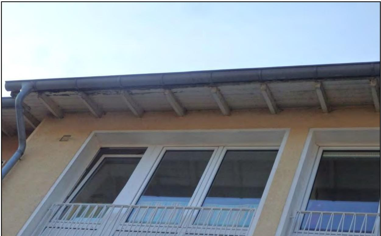
**Abbildung 6: Spalten im Bereich des Dachüberstandes, die als Einschlüpfen für Zwergfledermäuse genutzt werden können.**
