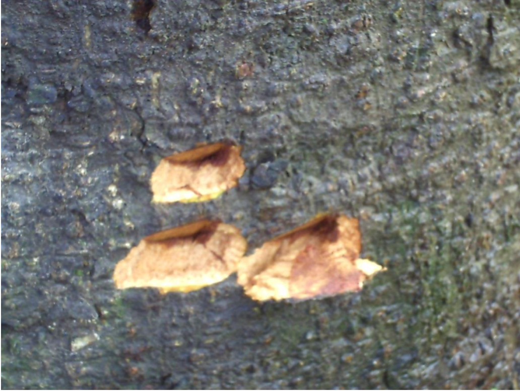
Erkennbare Fäule, tiefes Eindringen mit Messer problemlos möglich
