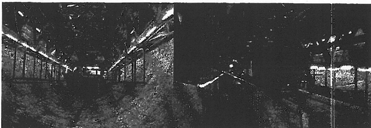
*Abb. 4: Paralleler Sohlausbau unterhalb der TVM-Nachläuferkonstruktion während des Tunnelvortriebs.*
