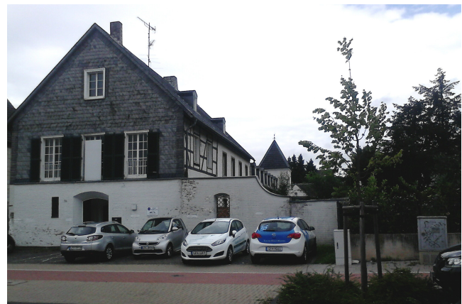
Das Gebäude auf der Düsseldorfer Straße 54 (Foto vom 27.08.2015)
