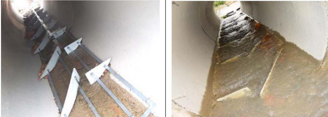
Abbildung 11-3: Lamellensystem, links Blick stromaufwärts, rechts Blick stromabwärts (Foto: Ross Kapitzke 2006, [U27])
