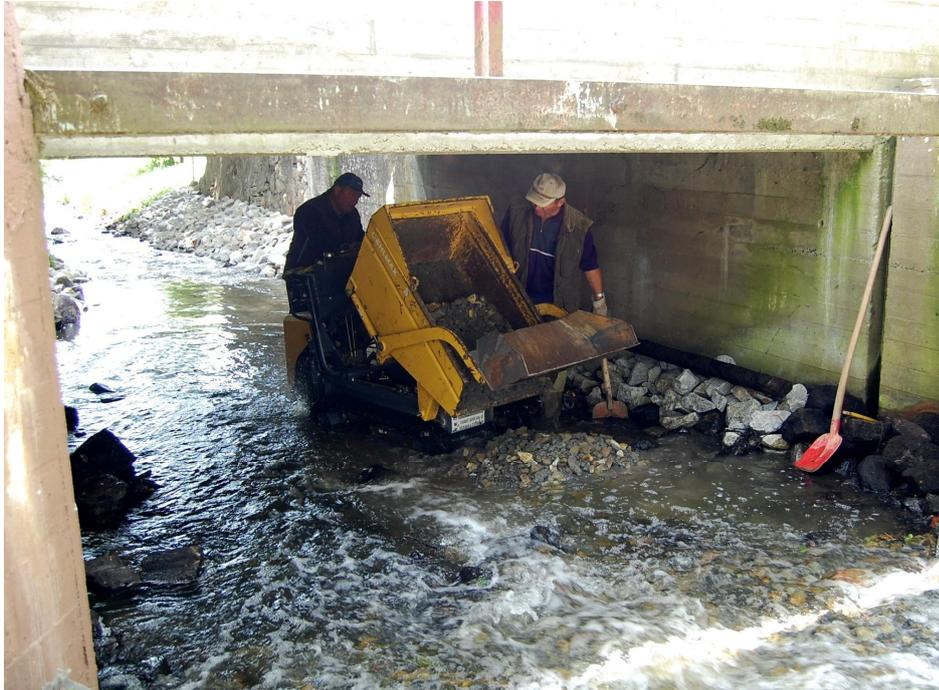
Abbildung 11-1: Einbau einer flächendeckenden Schüttsteinlage (Foto: Görlach)
