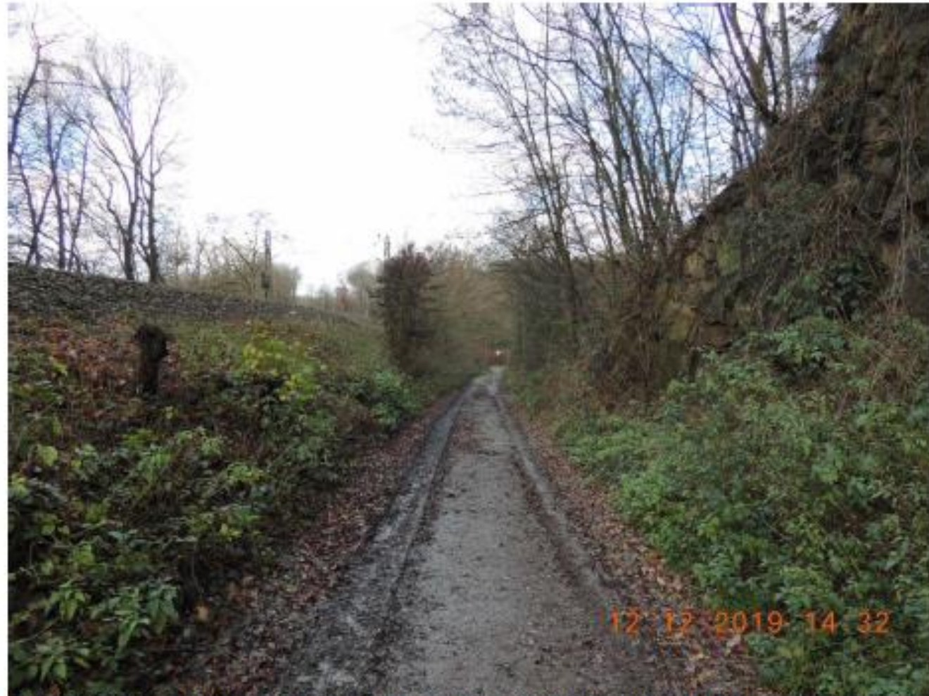
Blick auf den Beginn des Trassenverlaufs der Ableitung innerhalb der Wegefläche. (ca. km 46,4). Links des Weges innerhalb der Böschung befindet sich der geplante Anschluss aus der Tiefenentwässerung.
