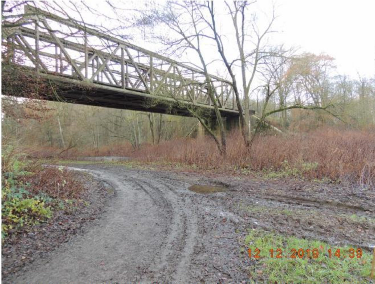
Blick auf den weiteren Trassenverlauf der Ableitung innerhalb der Wegefläche unmittelbar vor der Einleitungsstelle in die Wupper. (ca. km 45,95)
