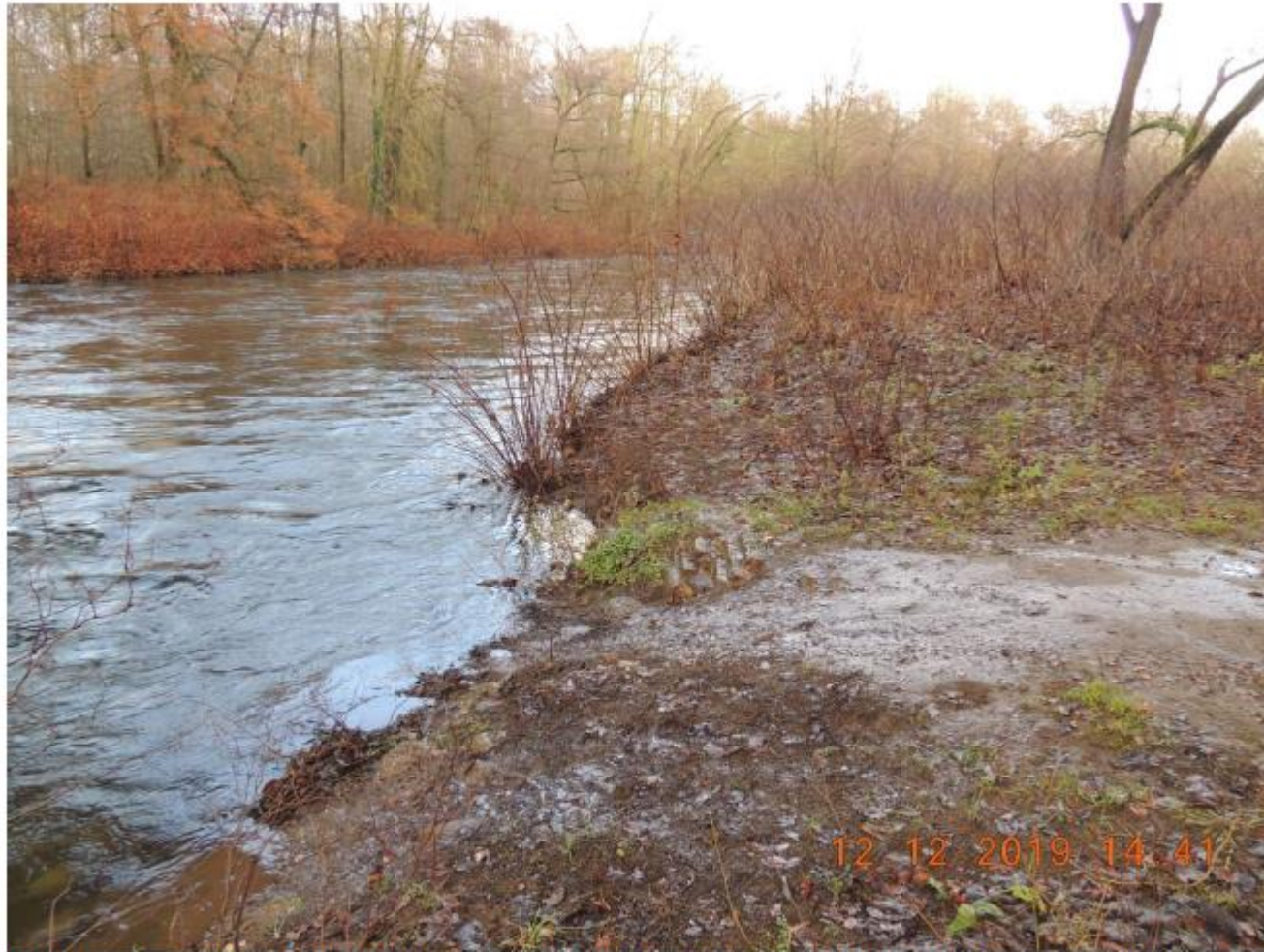
Die Einleitstelle E06 an der Wupper befindet sich unmittelbar unterhalb der Eisenbahnüberführung. Das Ufer ist mit einer Steinschüttung aus Wasserbausteinen befestigt.
