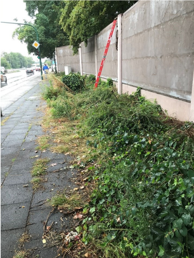
Lärmschutzwand nach Entfernung der Holzelemente (heutiger Zustand)
