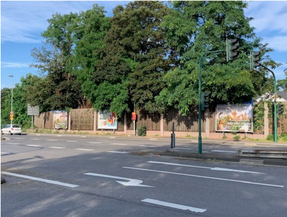
Lärmschutzwand vor der Entfernung der Holzelemente
