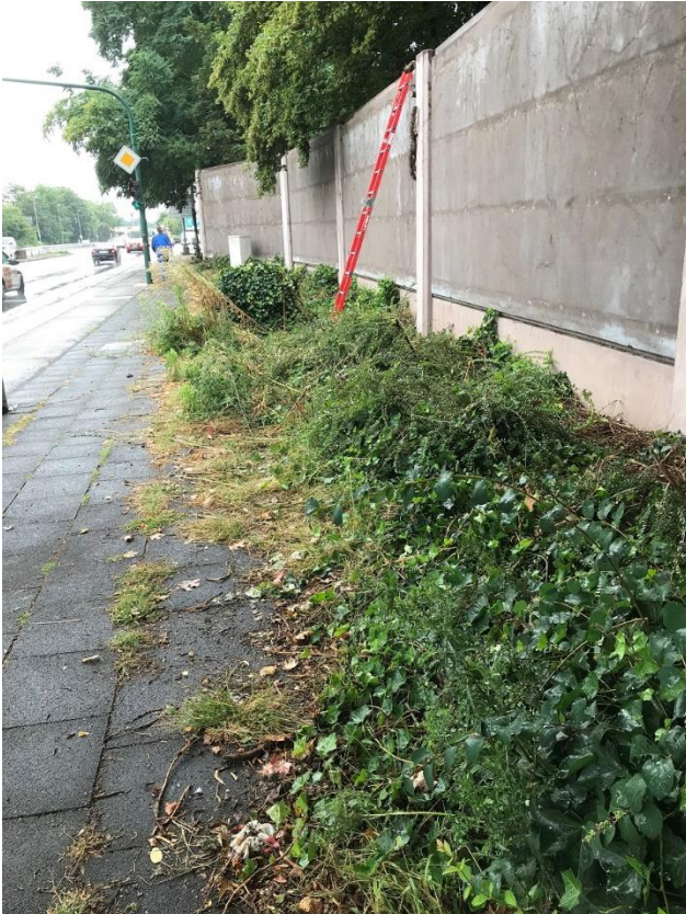
Lärmschutzwand nach Entfernung der Holzelemente (heutiger Zustand)
