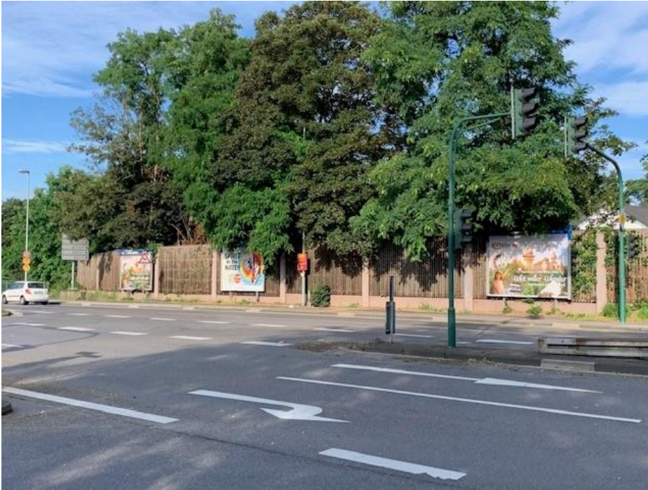
Lärmschutzwand vor der Entfernung der Holzelemente
