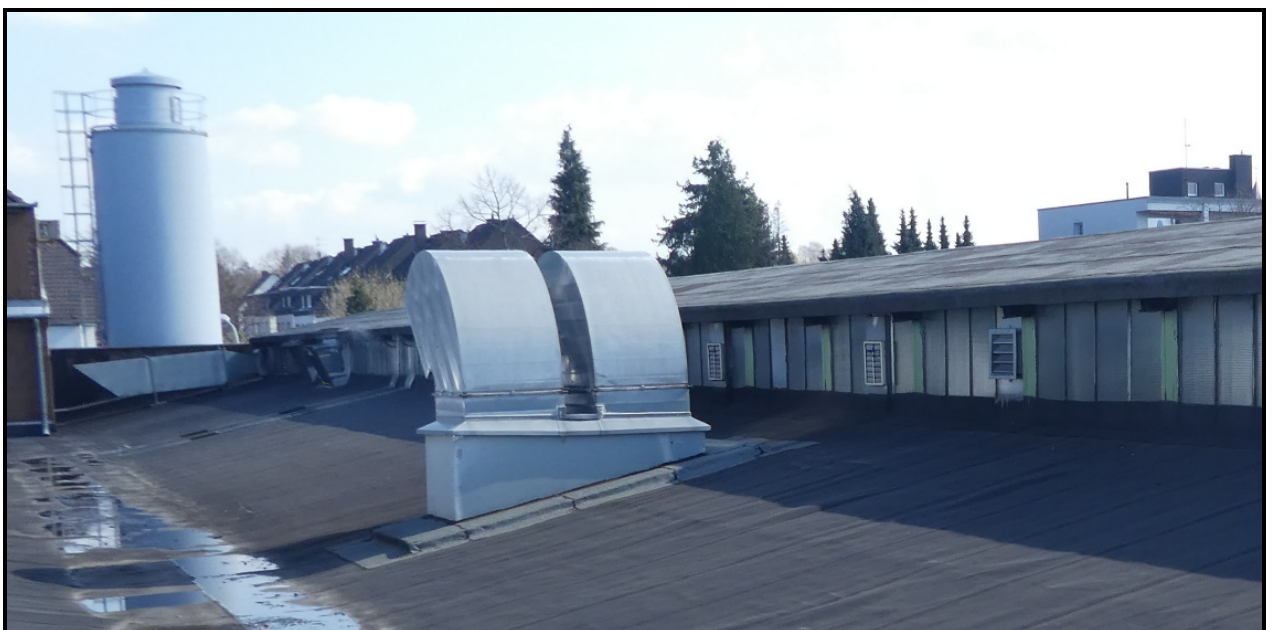
Abb. 3.1.3.2 Dachreiter über der WPA von Nordwesten
