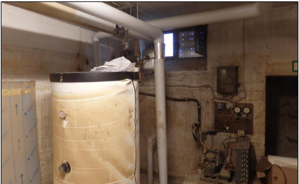
Abbildung 8: Teilansicht der Kellerräume ohne Eignung als Winterquartier für Fledermäuse.
