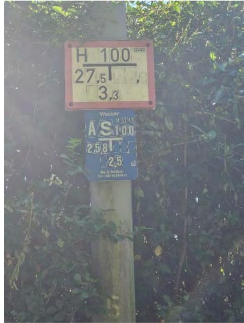
Abbildung 18: Hinweisschilder zur Gas- & Wasserleitung auf dem Auerweg
