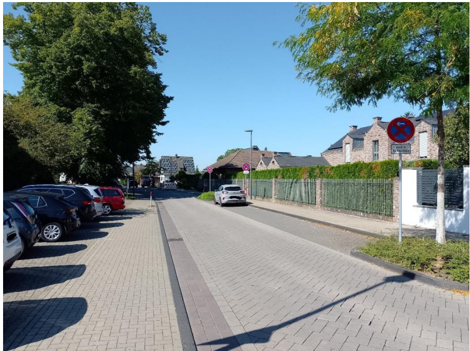
Abbildung 2-15: Ringstraße, vor Haus Nr. 73, Blick in Richtung Westen
