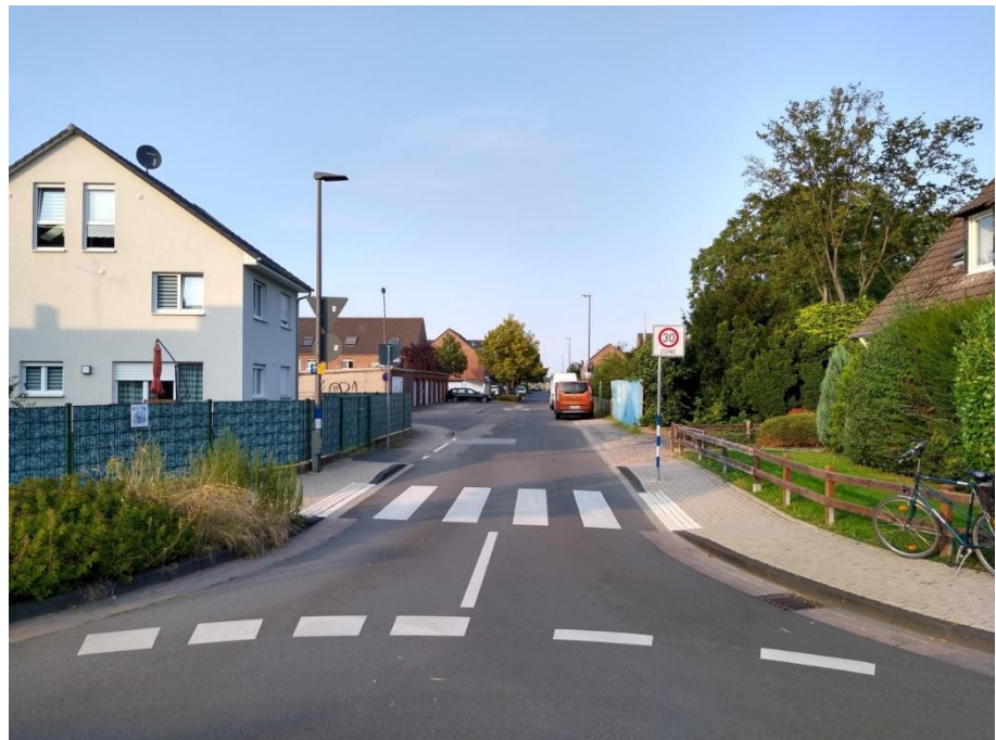
Abbildung 7-1: Einfahrt in die Weinhäuserstraße vom Knotenpunkt Ringstraße/ Weinhäuserstraße (Blick in Richtung Norden). Aufnahme: 18.09.2021
