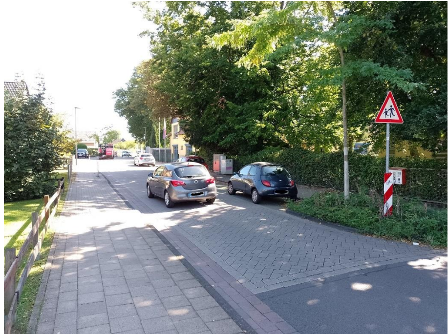
Abbildung 2-9: Ringstraße, Blick vom Kreisverkehr in Richtung Osten
