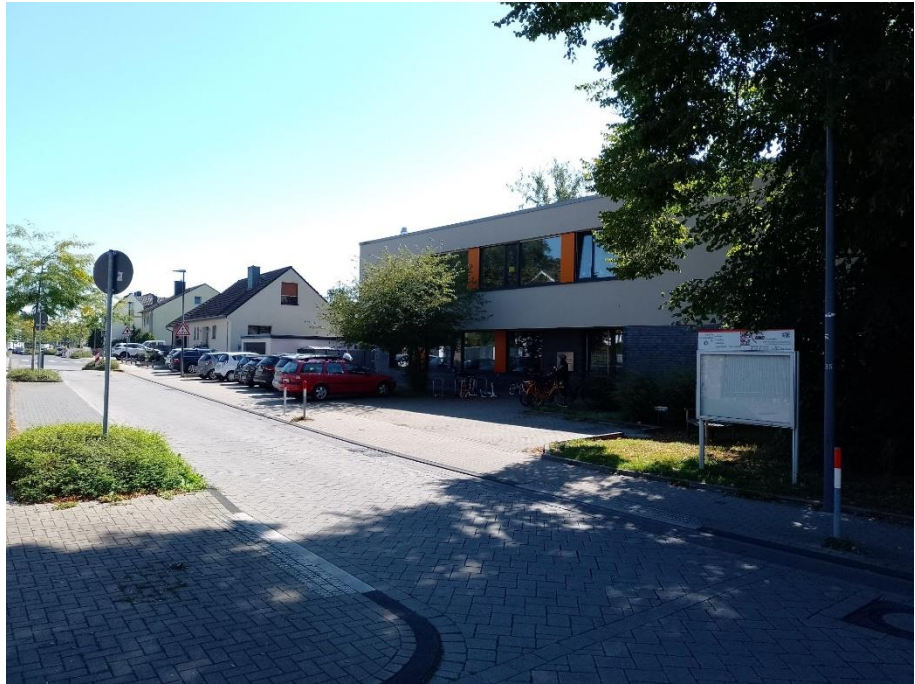
Abbildung 2-14: Ringstraße, vor Haus Nr. 73, Blick in Richtung Osten
