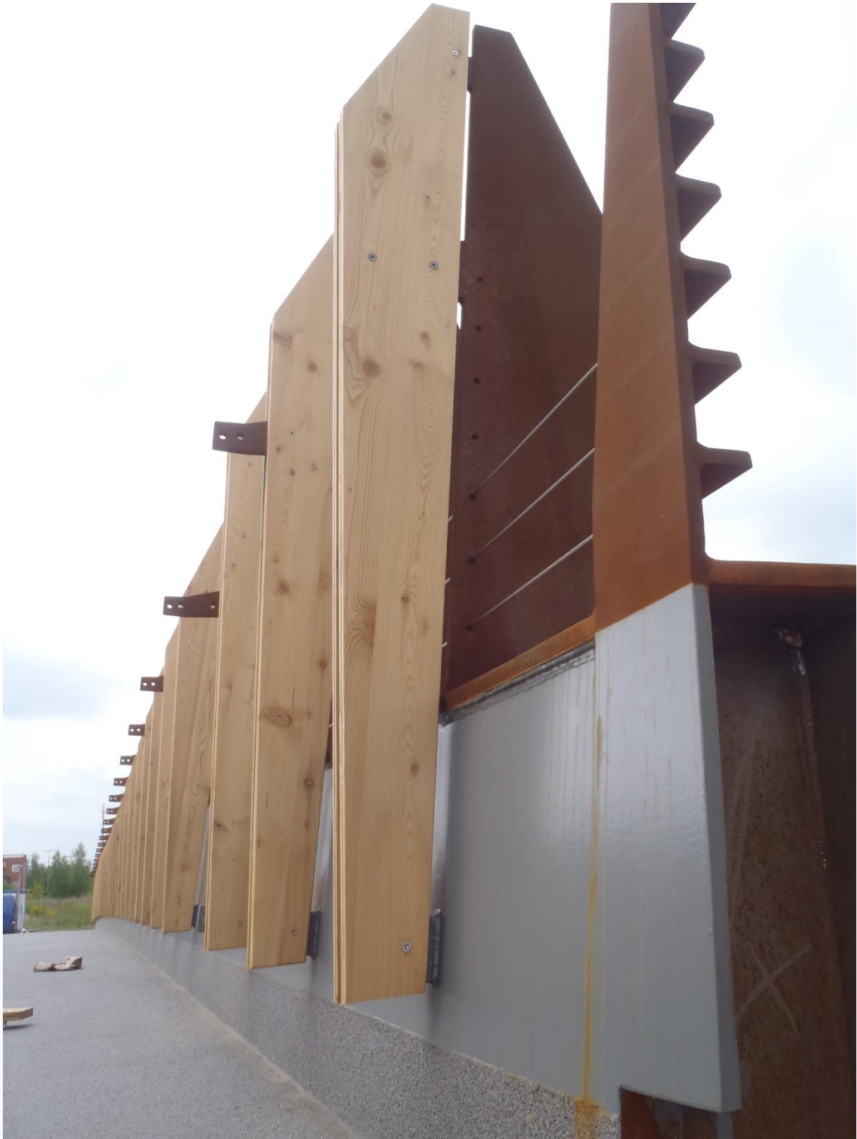
Abbildung 1: Ansicht 2013 bei der Montage
