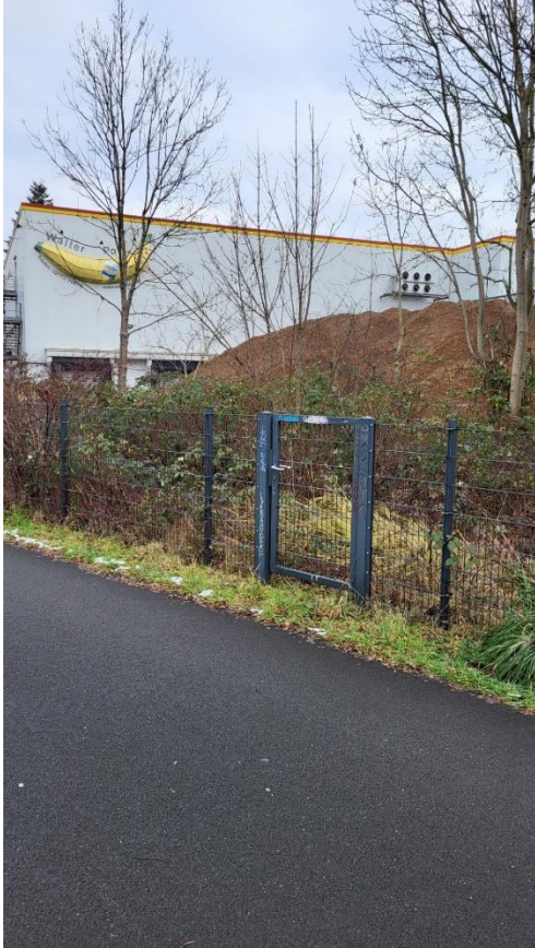
Foto 1 (Blick von der Trasse zum Ausweichstandort mit Tür)
