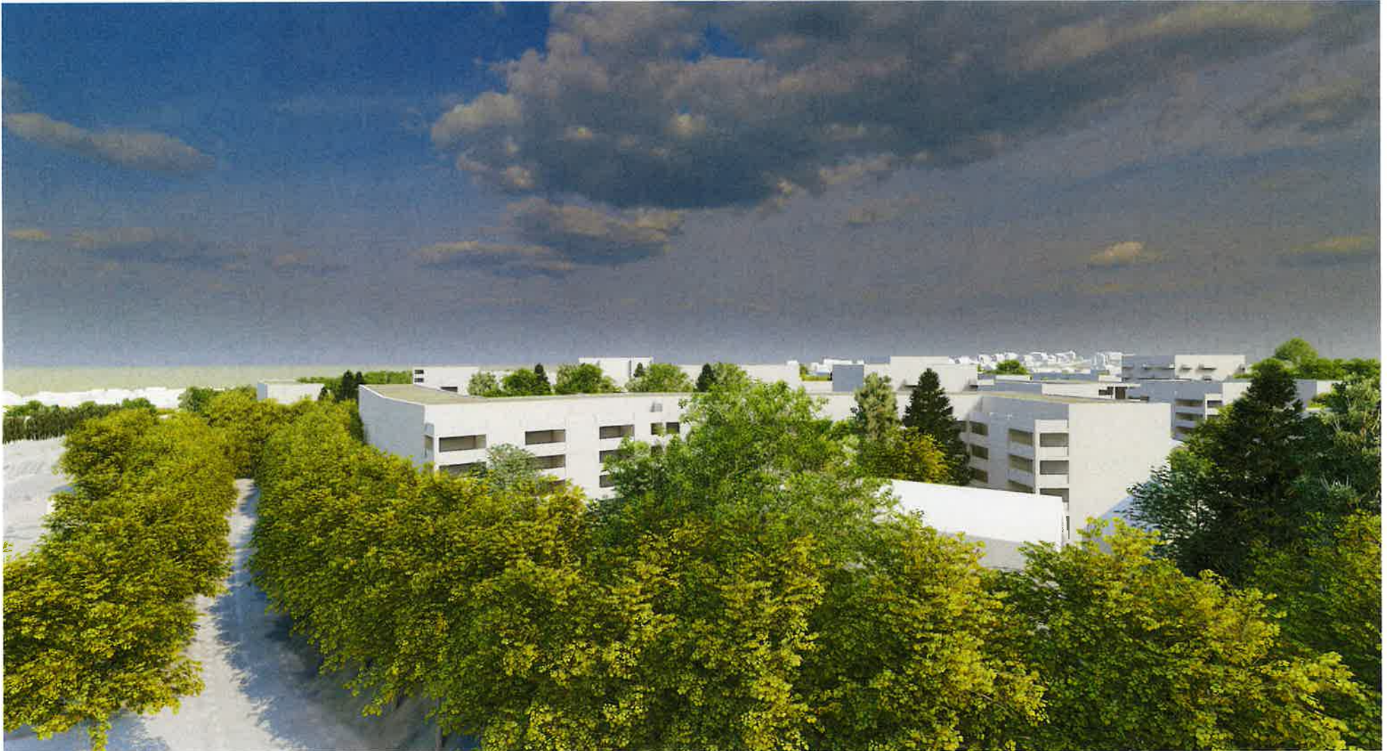
Abbildung 45 Gesamtschau von Süden
