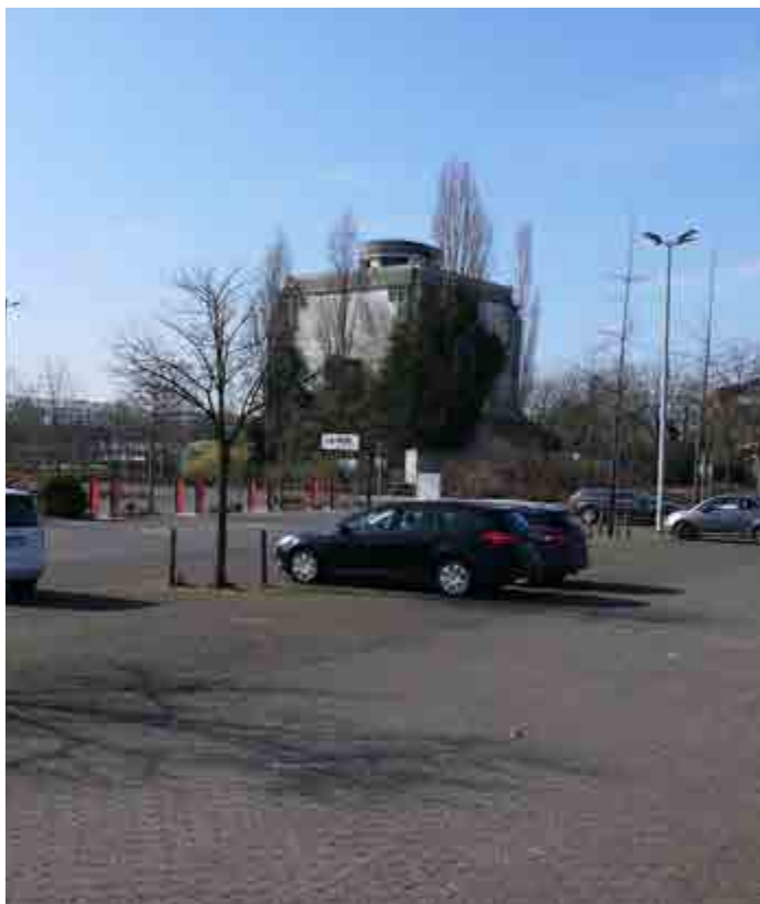
Abb.: Parkplatzfläche an der Schiessbergstraße (Q: s+w plus)
