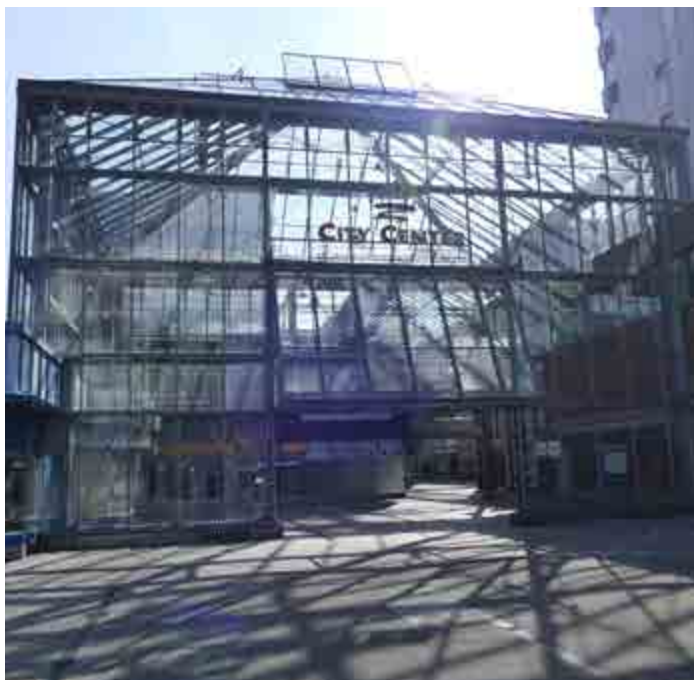
Abb.: Eingangsbereich City C zwischen Bahnhof und Friedrich-Ebert-Platz (Q: s+w plus)
