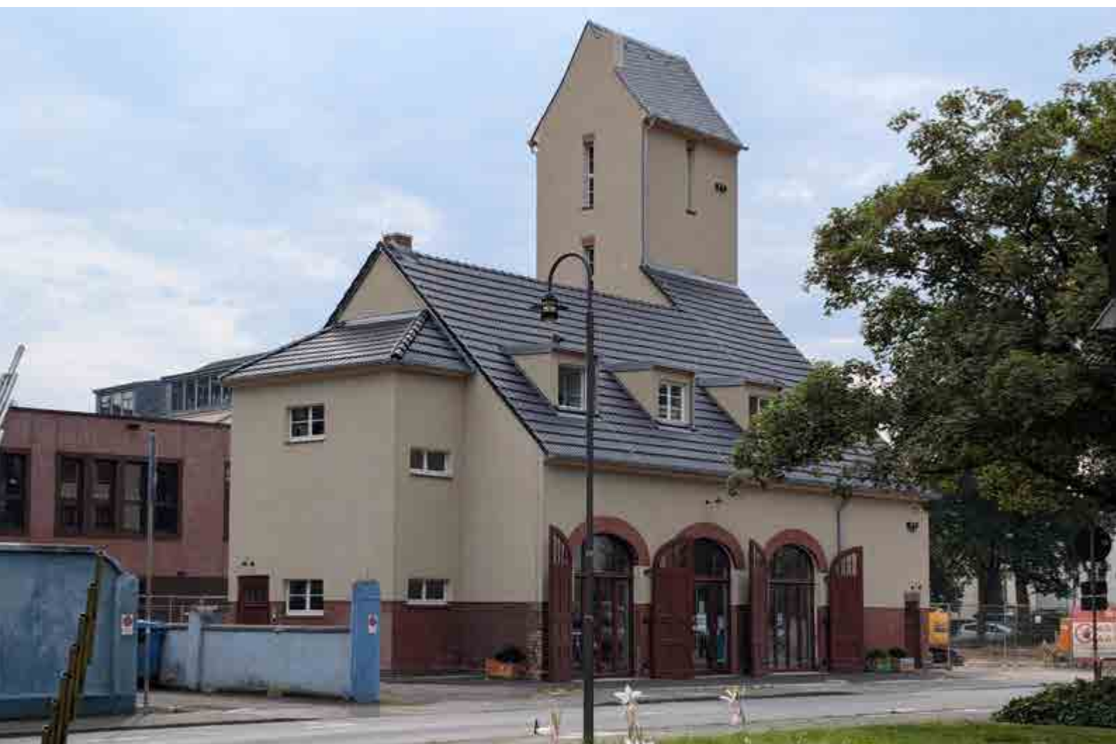
Abb.: Quartierstreffpunkt Dönhoffstraße in der alten Feuerwache (Q: Stadt Leverkusen)
