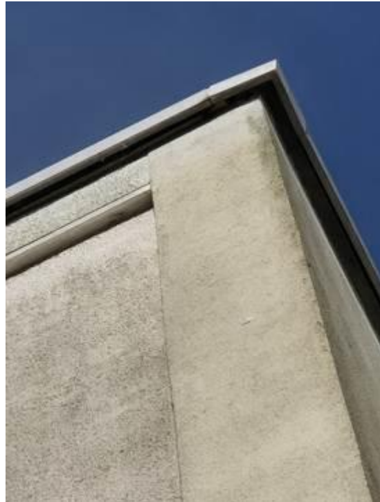
Abb. 8 Spalt zwischen Gitter zum Lückenschluss und Dachkante (Kraft.Raum. 2025)
