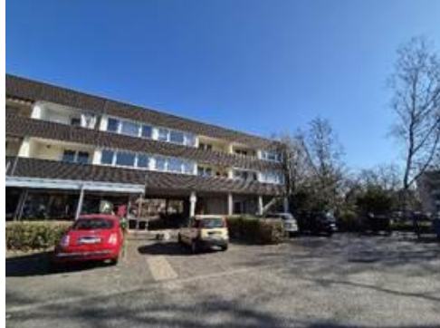
Abb. 10 Memelstraße 4-8 mit Flachdach und Schieferfassade (Kraft.Raum. 2025)
