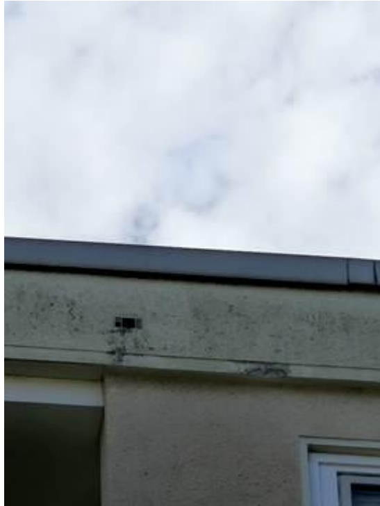
Abb. 6 Öffnung in Lüftungsschlitze Samlandstraße 8 (Kraft.Raum. 2025)
