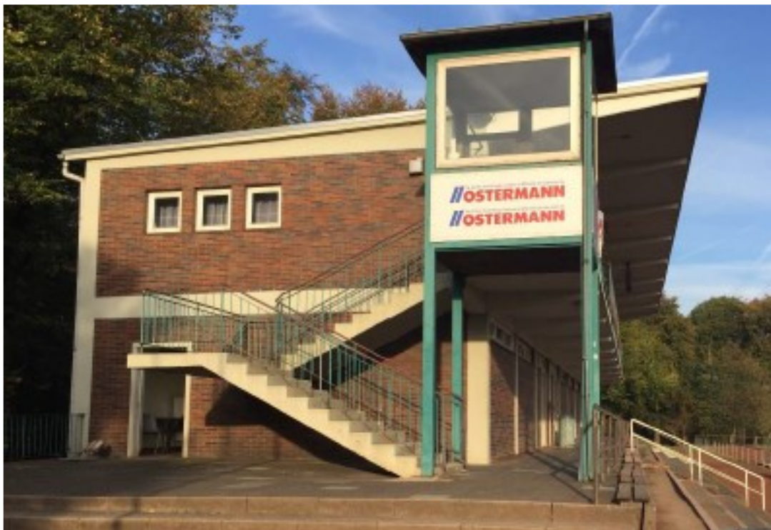
Abbruch des Platzwärterhochsitzes
