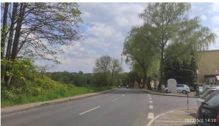
Abb. 3: Blick nach Süden entlang des Bohofsweges ab Höhe der Einmündung „Wilmsdorfer Straße“
