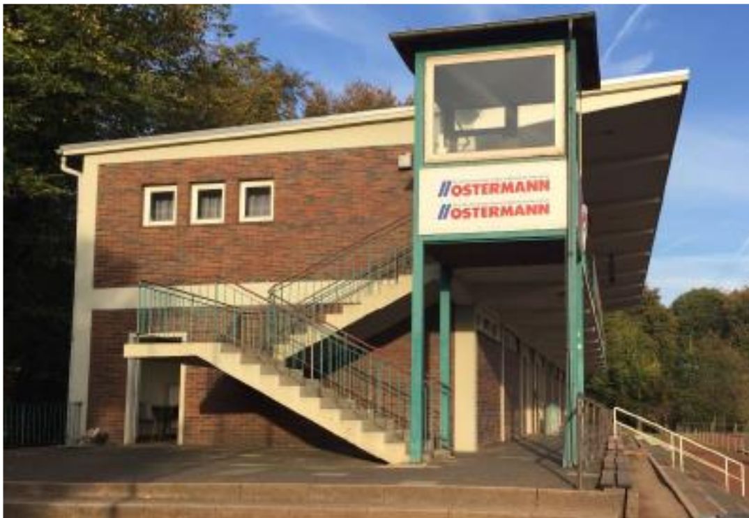
Abbruch des Platzwärterhochsitzes
