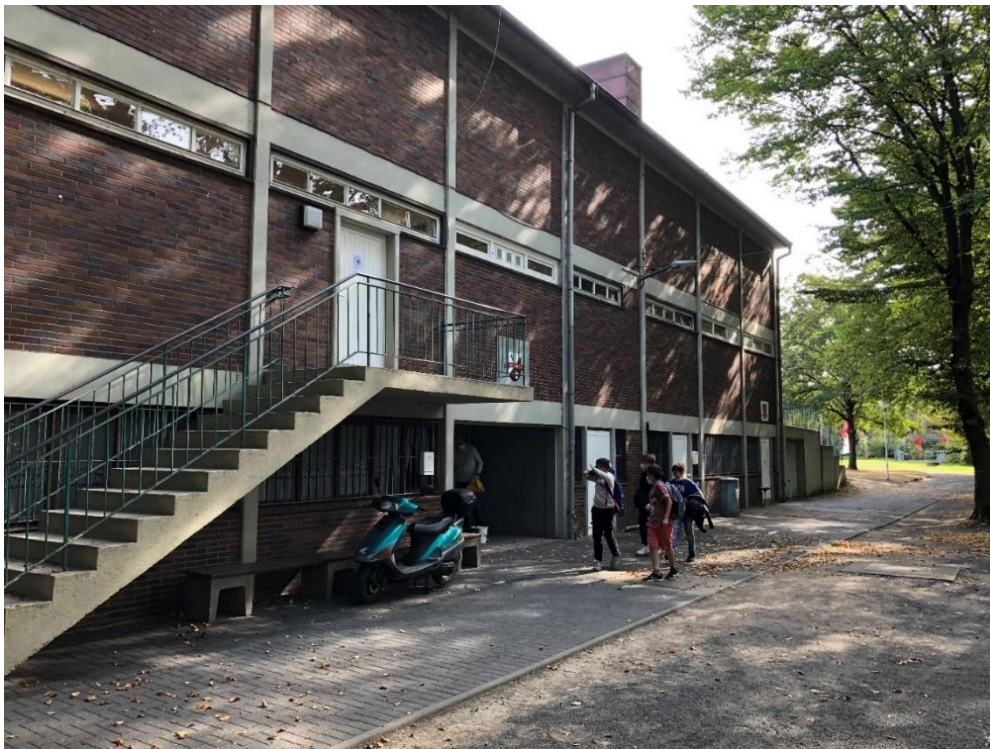
Rückseite Terrassenhaus im Bestand
