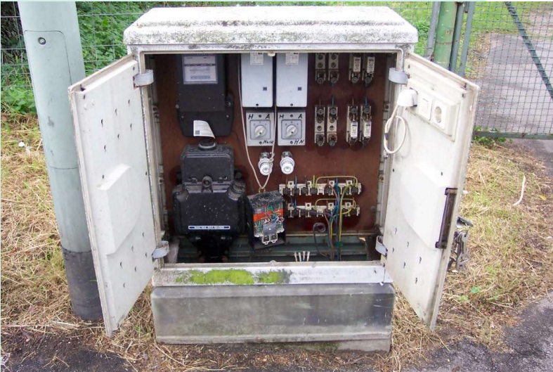
Zustand der Altanlagen als Beispiel
