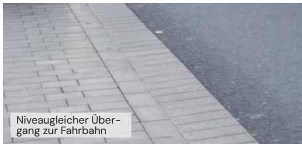
Betonsteinpflaster in Reihenverband
