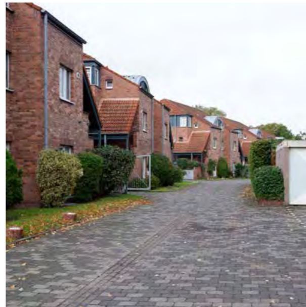
Zone Wohnsiedlung - Gerhard-Domagk-Straße
