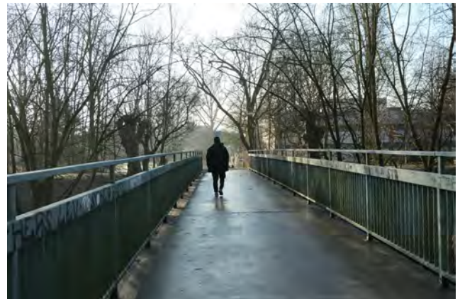
Brücke über die Dhünn; Blickrichtung Süden
