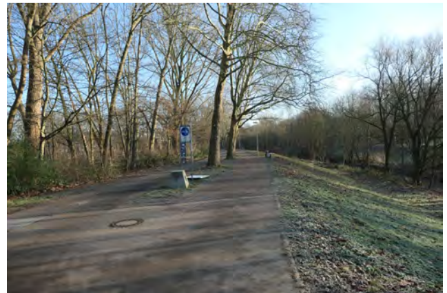
Fuß- / Radweg auf der nördlichen Dhünnseite; Blickrichtung Tannenbergstraße nach Osten
