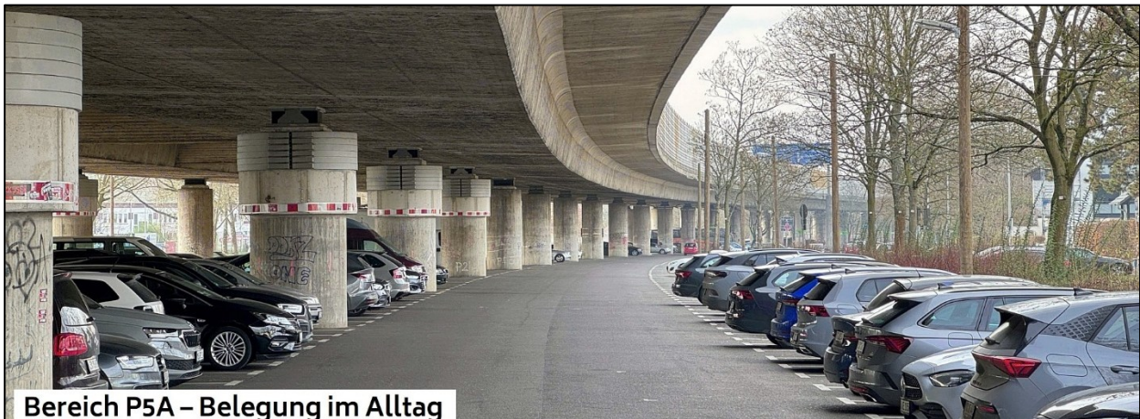
Abbildung 8: Alltagssituation - Belegung unter der Stelze im östlichen Bereich (P5A) [eigene Aufnahme]
