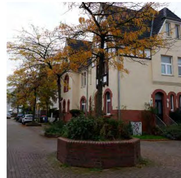
Zone Wohnkolonie – Vant-Hoff-Straße
