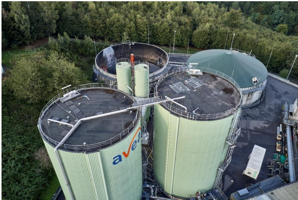
Abbildung 11: Kombinierte Vergärungs- und Kompostierungsanlage Leppe
