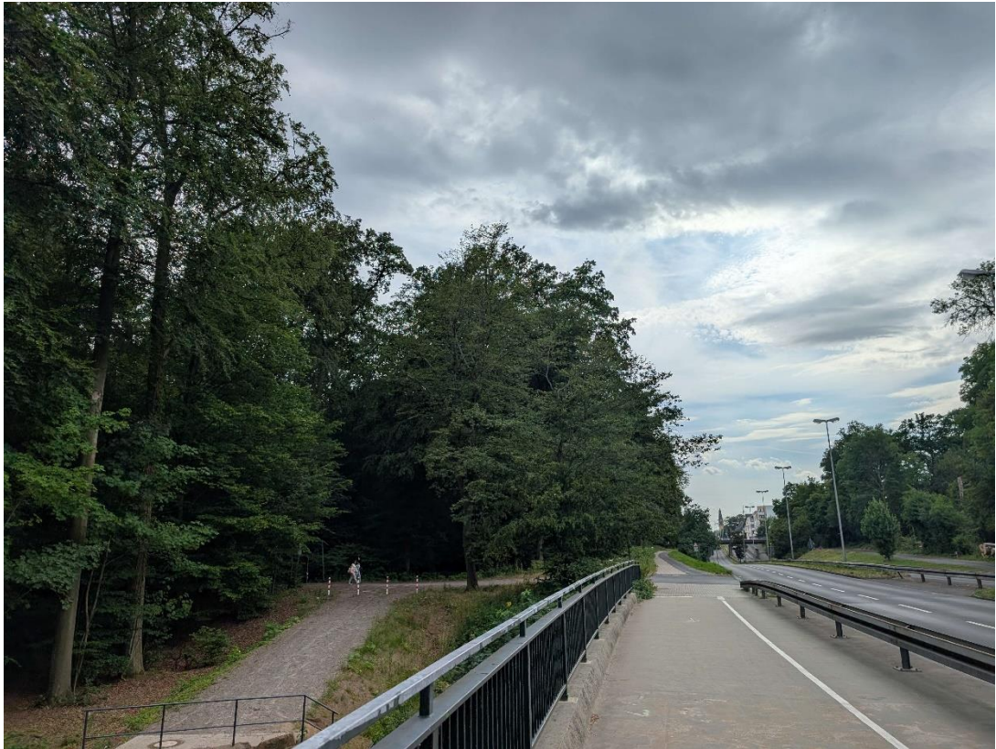
Bild 5: rechts: Gustav-Heinemann-Straße links: neue geschotterte Zuwegung zur neuen Einleitstelle an die Dhünn der Technischen Betriebe der Stadt Leverkusen.
