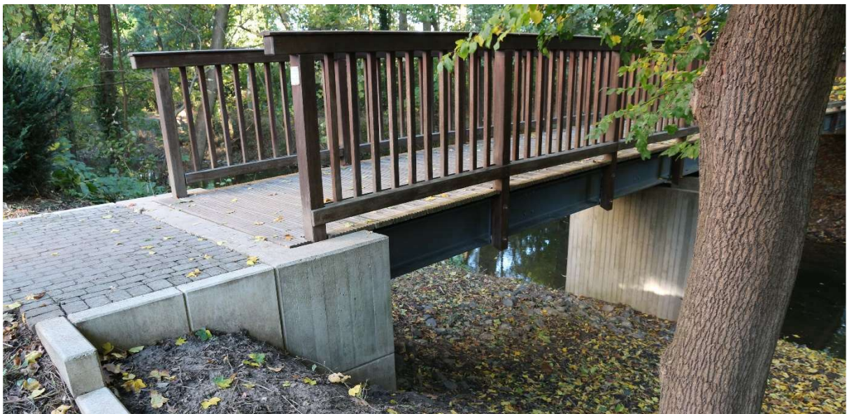
Abbildung 1: Fuß- und Radwegebrücke der Technischen Betriebe Leverkusen (TBL) bei km 6+731
