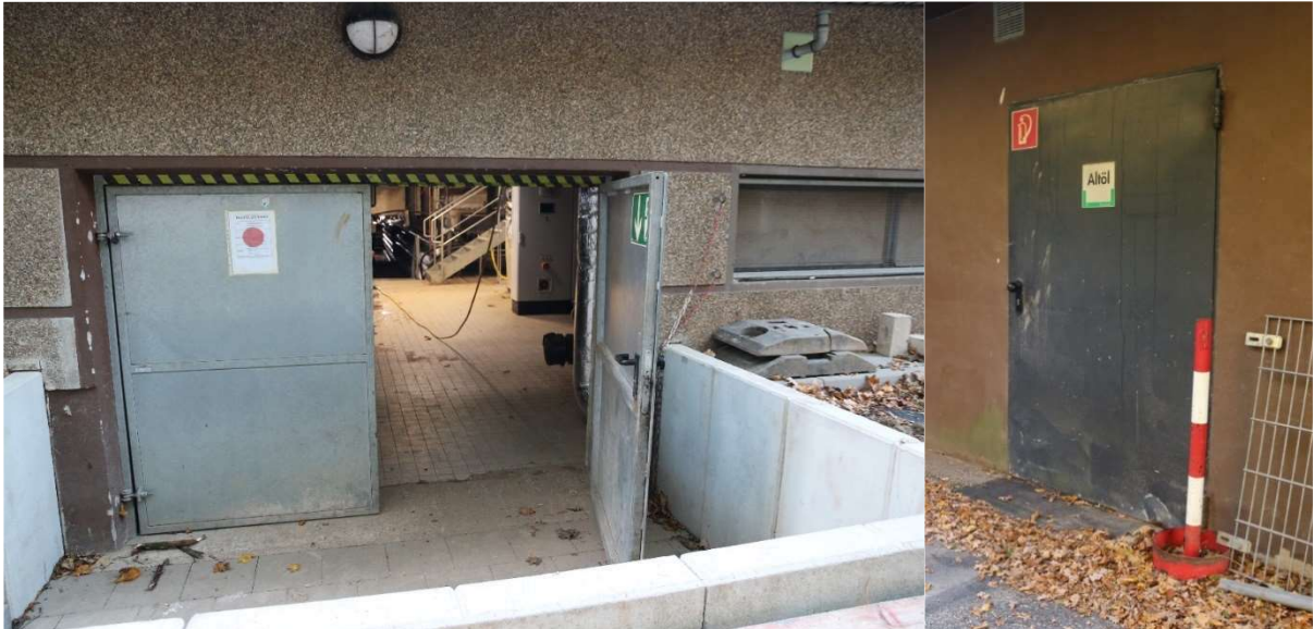
Abbildung 20: M1.2.1 Beispiele der Öffnungen am Gebäude 8
