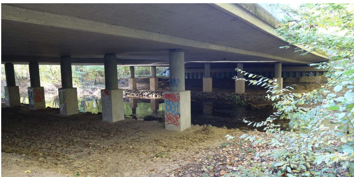
Abbildung 2: Brückenbauwerk Gustav-Heinemann-Straße (Dhünn km 6+270)
