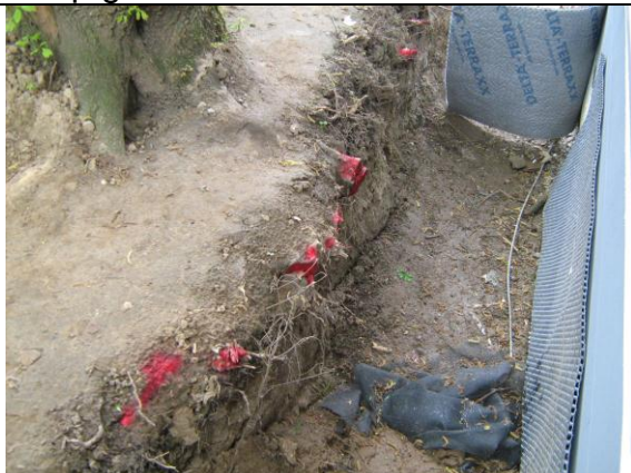
Wurzelabgrabungen (Wurzeln z. T. mit roter Farbe markiert)
