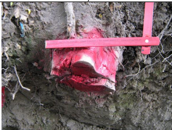
Wurzelabgrabungen bis 15cm Durchmesser
