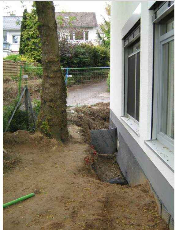
Grabarbeiten wegen Gebäudesanierung
