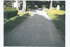
Haupterschließung für Fußgänger mit Unebenheiten (Wurzeln und schadhafte Wegedecke aus verfestigtem Hüttenkalk) - Zustand C
