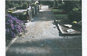
Kurzzeitig nach Aufbringen einer neuen Deckschicht treten Beeinträchtigungen durch Unkraut und Regenwurmtätigkeit auf - Zustand C
