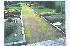
Kurzzeitig nach Aufbringen einer neuen Deckschicht treten Beeinträchtigungen durch Unkraut und Regenwurmtätigkeit auf - Zustand C
