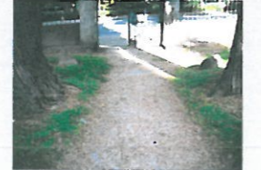
Haupterschließung für Fußgänger mit Unebenheiten (Wurzeln und schadhafte Wegedecke aus verfestigtem Hüttenkalk) - Zustand C
