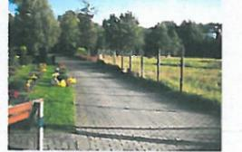
Die Haupterschließungen im östlichen Teil sind überwiegend mit Betonverbundpflaster befestigt und insgesamt gut ausgebaut - Zustand A
