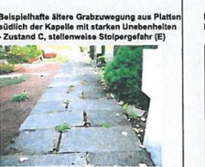
Beispielhafte ältere Grabzuwegung aus Platten südlich der Kapelle mit starken Unebenheiten - Zustand C, stellenweise Stolpergefahr (E)
