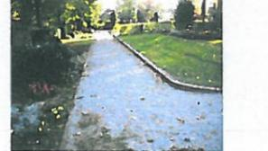
Von Grund auf sanierter Nebenweg mit Decksicht aus Splitt nach ca. vier Jahren Nutzungsdauer und wenig Pflegeaufwand - Zustand A
