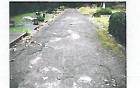
Fußweg mit Befestigung vermutlich aus älterer und zunehmend schadhafter Hüttenkalk-Deckschicht - Zustand E
