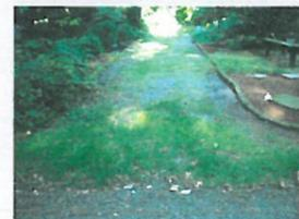
Wegabschnitt im älteren Friedhofsteil mit Gefahrenstellen infolge Baumwurzeln, Deckenschäden und Kantenstein - Zustand E
