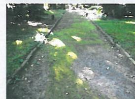
Sanierter Wegeabschnitt mit Splittdecke und aufkommendem Bewuchs - Zustand B
