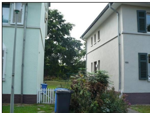
Bebauung/ LSW mit vorbeifahrendem Zug
