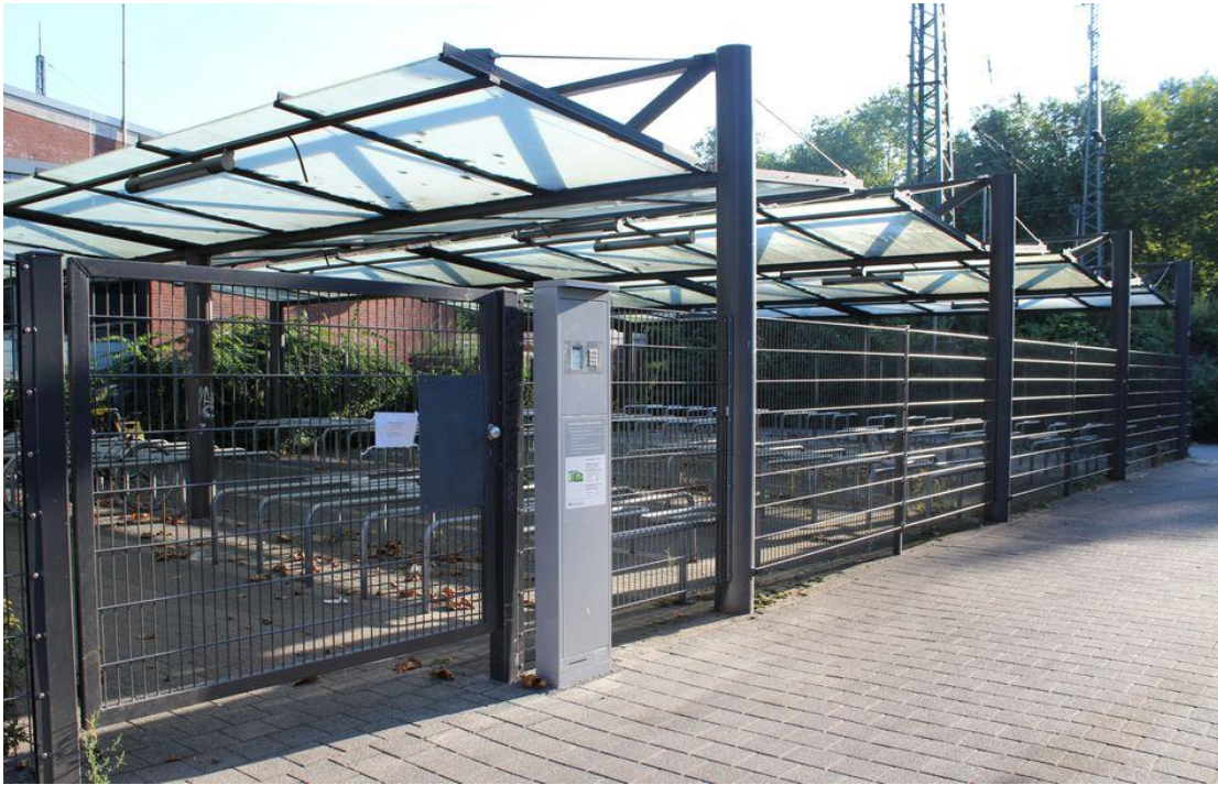
Überdachte Radparkanlage Beispiel Recklinghausen
