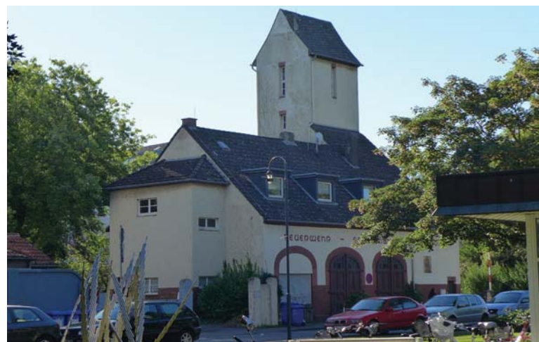
Alte Feuerwache an der Moskauer Straße
