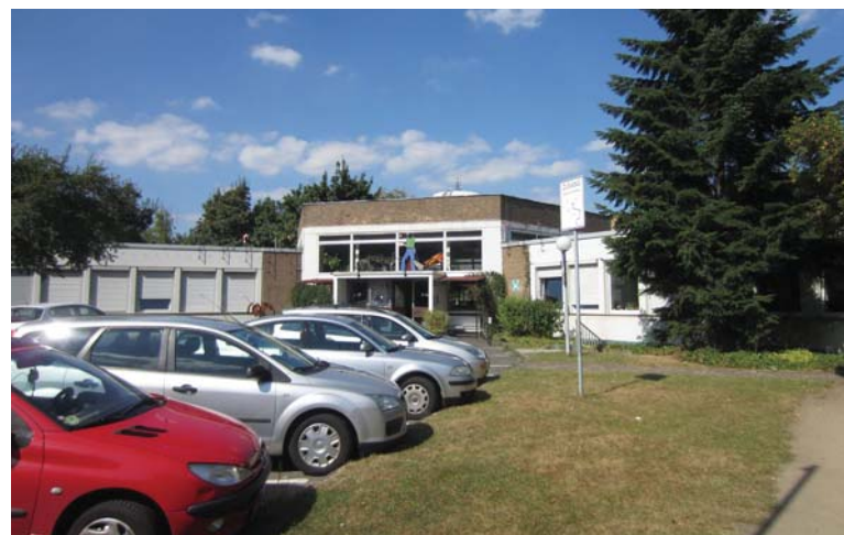
Gebäude der Jugendwerkstatt mit aktueller Lage an der Dhünnstraße 12d
