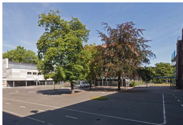
Realschule Am Stadtpark - an den Stadtpark angrenzender Schulhof
