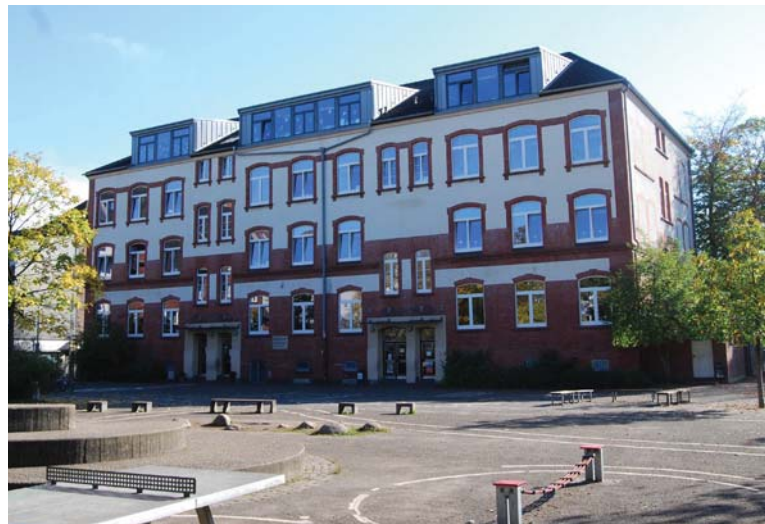
Historisches Schulgebäude der GGS Dönhoffstraße
