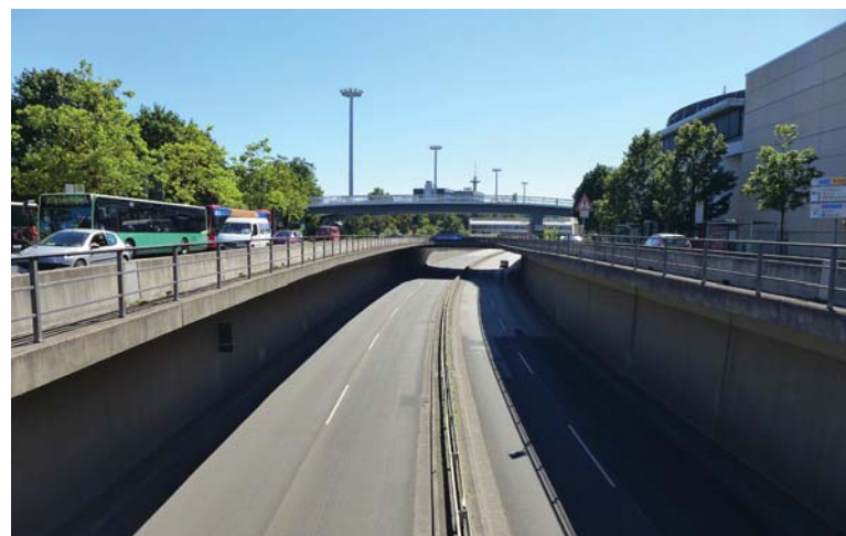
B8 mit Y-Brücke für Fußgänger und Radfahrer
