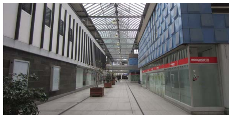
Leerstehende Bausubstanz im City C
