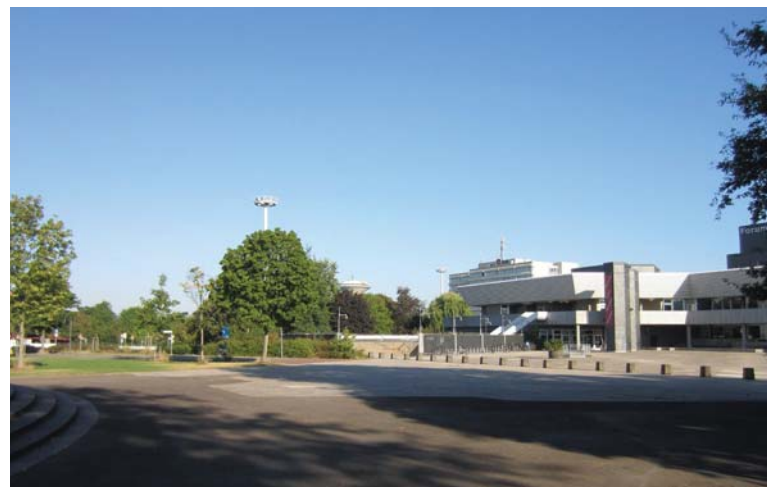
Ergänzende Baukörper auch im Umfeld des Forum
