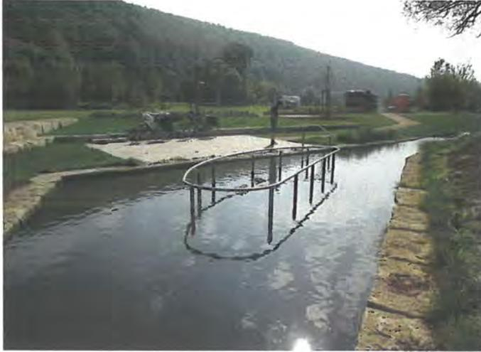
Das Foto zeigt die Tretstelle mit Blick in Südrichtung zur Mittagszeit. Sie ist mit Natursteinen rundum befestigt. Die Wassertiefe ist am Geländer etwa wadentief. Als Untergrund wurde ein feiner Kies gewählt. An der Eintrittsstelle sind Natursteinstufen mit einem Geländer (VA-Stahl). Hier ist ein Bereich plattiert. Eine Steinreihe lädt zu einer Sitzpause ein.
