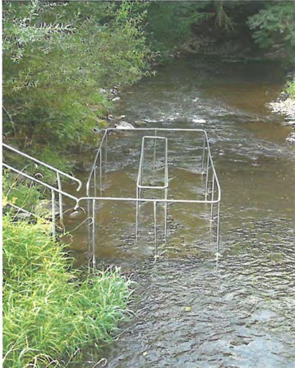
Das Foto zeigt die Tretstelle in Flussrichtung. Die Anlage wurde von uns nicht besichtigt. Die Stangen sowie die Treppe werden im Winterhalbjahr abgebaut, unter anderem damit sich bei Hochwasser kein Treibholz an dem Gestänge verhakt.
